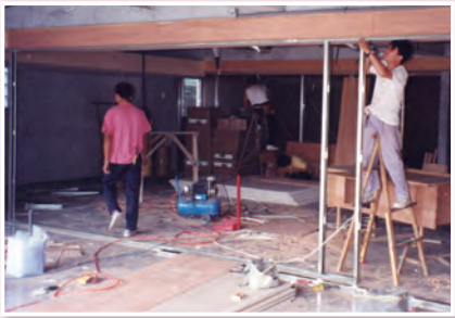
▲長沙街會所裝潢施工情形之三
