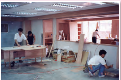
▲長沙街會所裝潢施工情形之五
