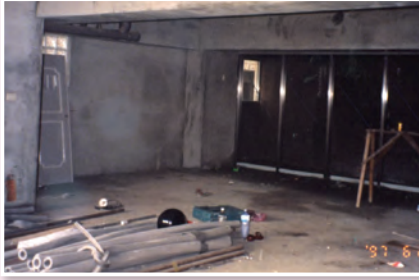
▲長沙街會所裝潢施工情形之一
