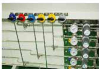
氣體配管工程 供氣系統
