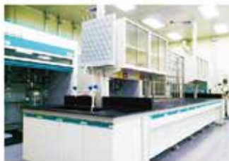
中央桌・邊桌・藥品櫃・通風櫃 實驗室建設
