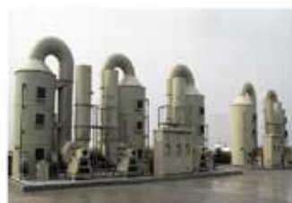
洗滌塔過濾箱 廢氣處理
